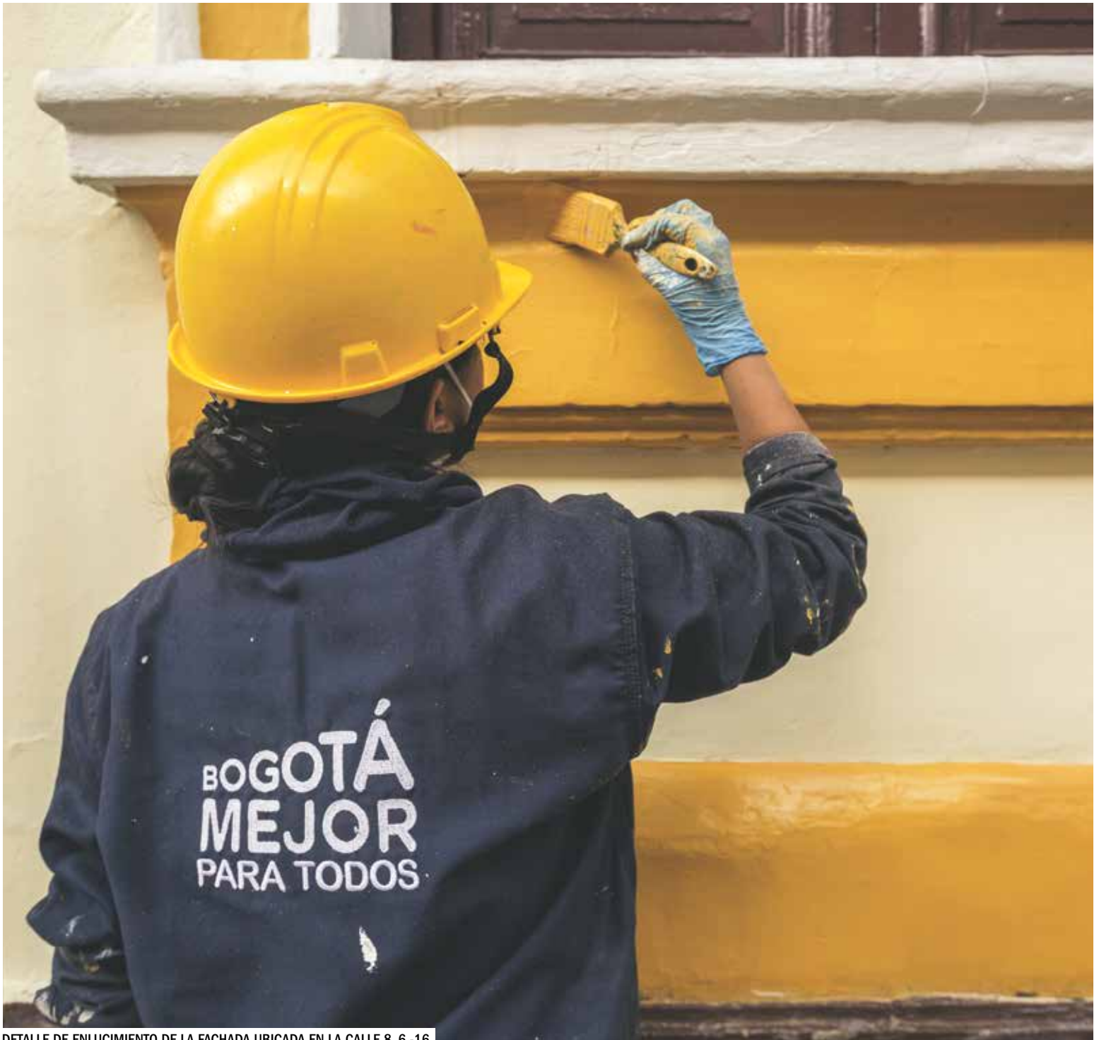
DETALLE DE ENLUCIMIENTO DE LA FACHADA UBICADA EN LA CALLE 8, 6 -16
