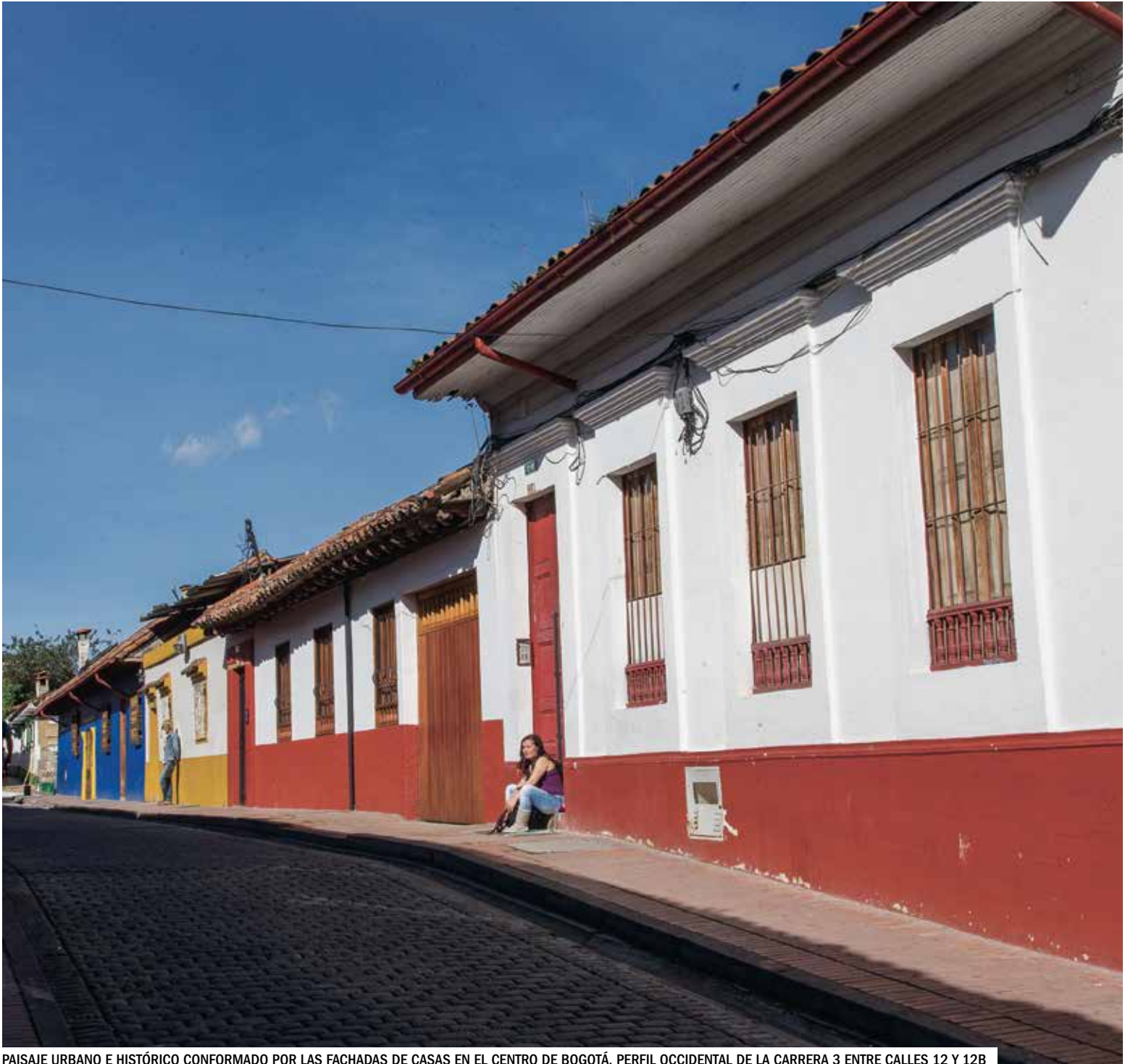
PAISAJE URBANO E HISTÓRICO CONFORMADO POR LAS FACHADAS DE CASAS EN EL CENTRO DE BOGOTÁ. PERFIL OCCIDENTAL DE LA CARRERA 3 ENTRE CALLES 12 Y 12B
