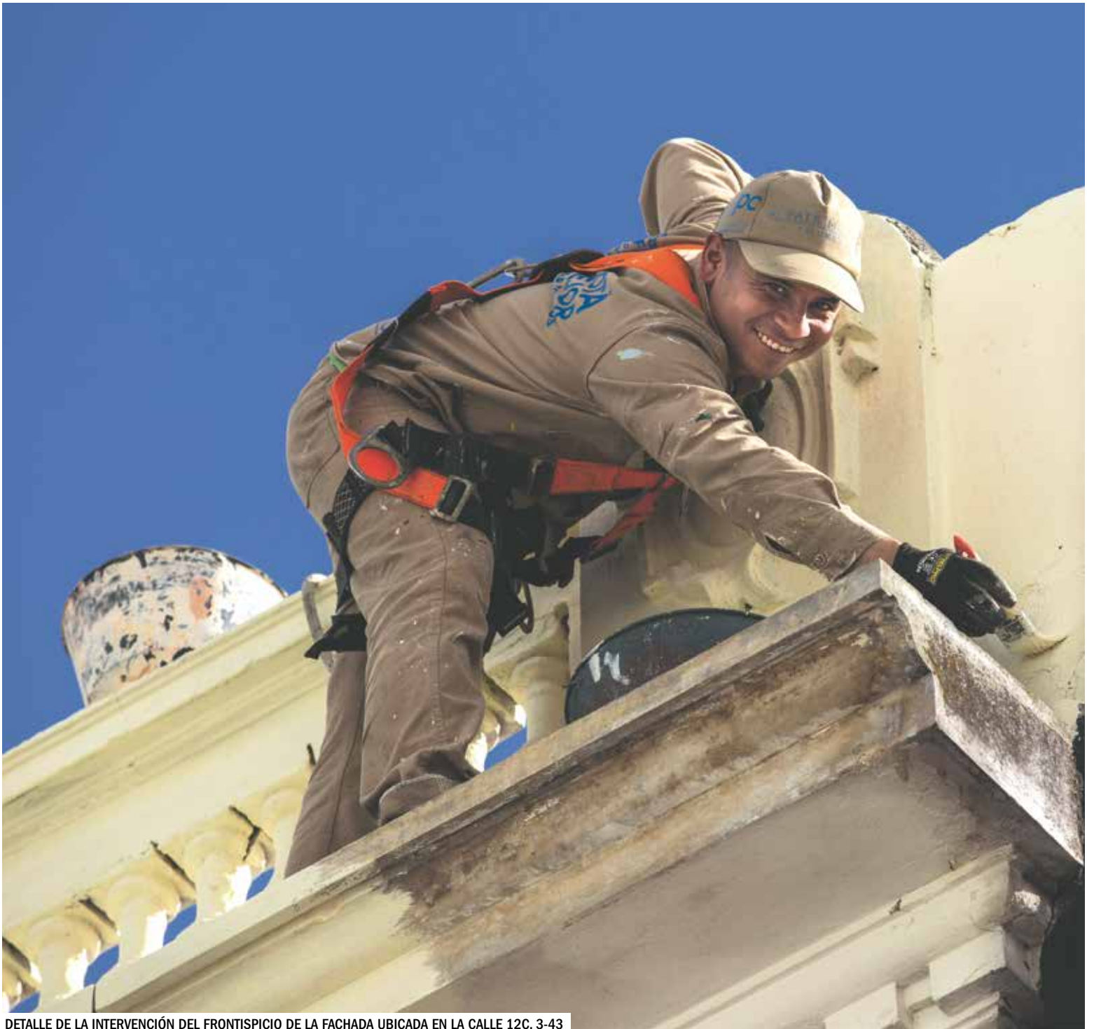
DETALLE DE LA INTERVENCIÓN DEL FRONTISPICIO DE LA FACHADA UBICADA EN LA CALLE 12C, 3-43
