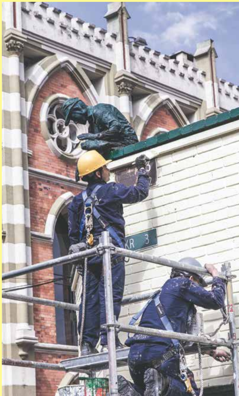
ACTIVIDADES DE ENLUCIMIENTO REALIZADAS A TRAVÉS DEL PROGRAMA, EN LA FACHADA UBICADA EN LA CALLE 3, 12-07
